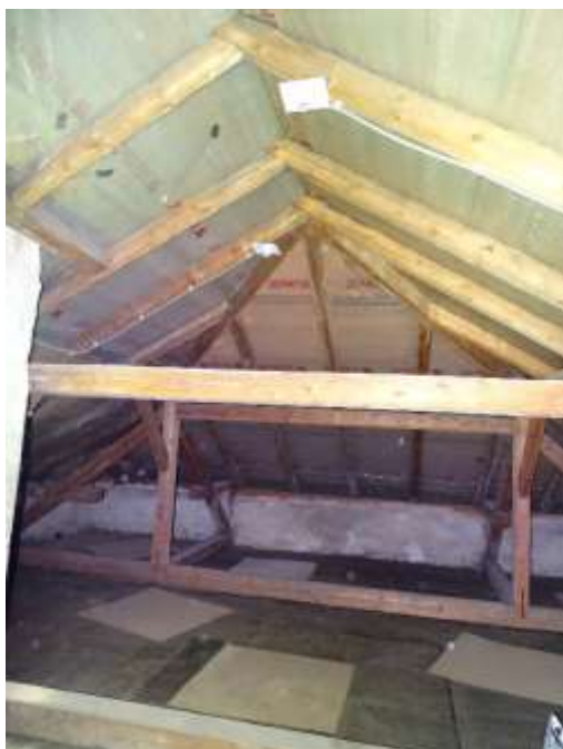
ESN.10 – umístění nového stožáru na stávající trámy
