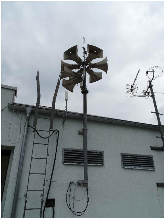
ES.8 – stávající siréna – ukotvení stožáru
