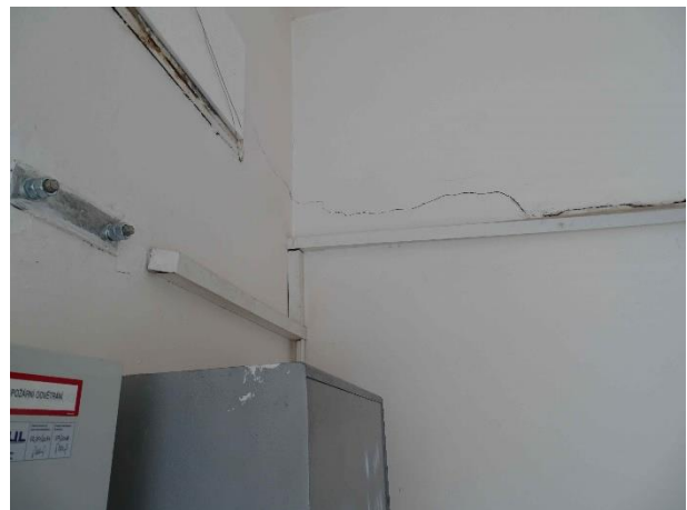
ES.8 – stávající průrazy v prostoru střešní nástavby schodiště
