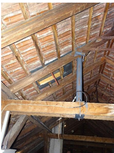
ESN.12 – stávající stožár sirény – kotvení
