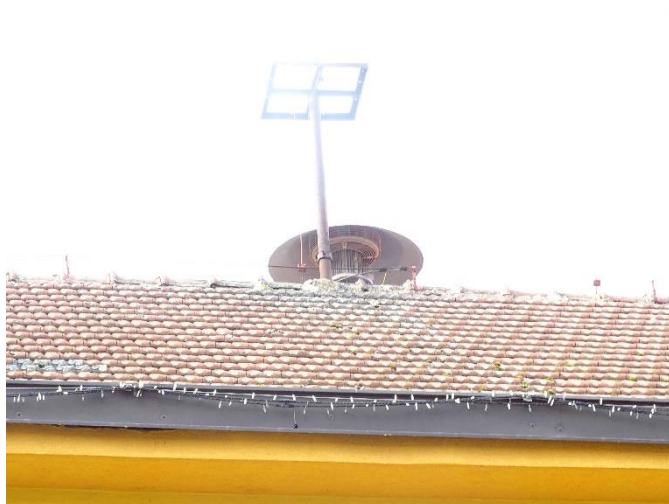
ESN.12 – stávající stožár sirény – příruba
