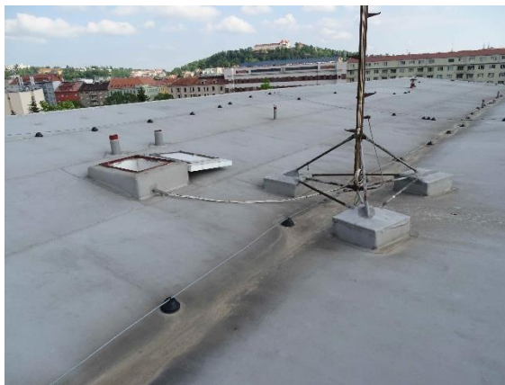
EST.15 – kotvení stožáru a stávající průchod na střechu
