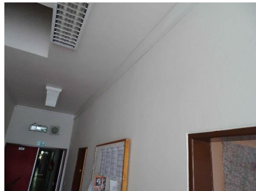
EST.6 – stávající trasa kabelů na chodbě
