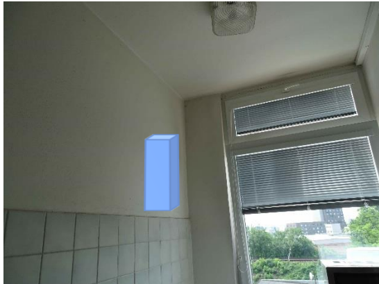
EST.6 – místo pro rozvaděč sirény (levá stěna u okna)
