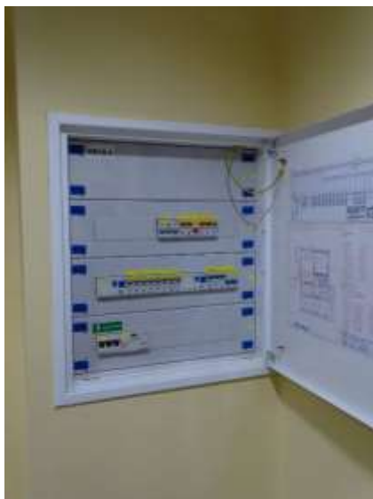
ESN.5 – stávající rozvaděč pro nový přívod sirény (bude doplněn o nový jistič a podružné měření)
