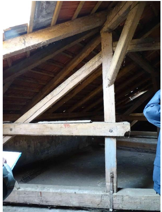
ESN.20 – místo pro nový stožár sirény – uchycení na trámy v půdním prostoru
