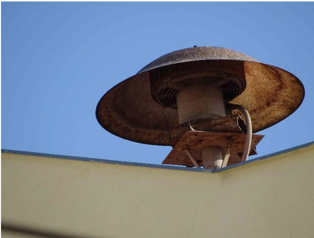
ESN.19 – stávající stožár sirény – příruba
