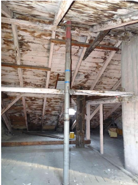
ESN.19 – stávající stožár sirény – průchod na střešku
