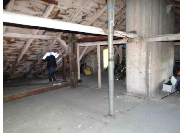
ESN.19 – stávající stožár sirény – kotvení
