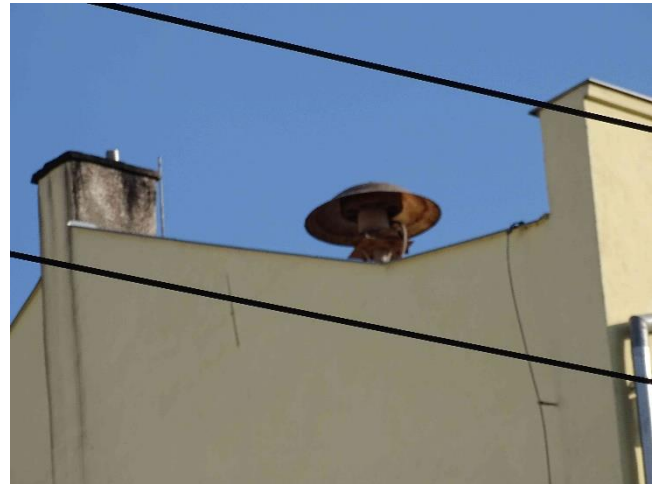
ESN.19 – stávající stožár sirény, umístění rotační sirény
