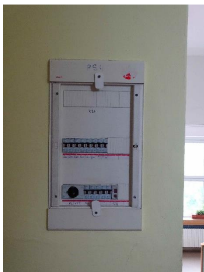
EST.14 – patrový rozvaděč NN bude doplněn o 1f jistič B10 a podružné měření
