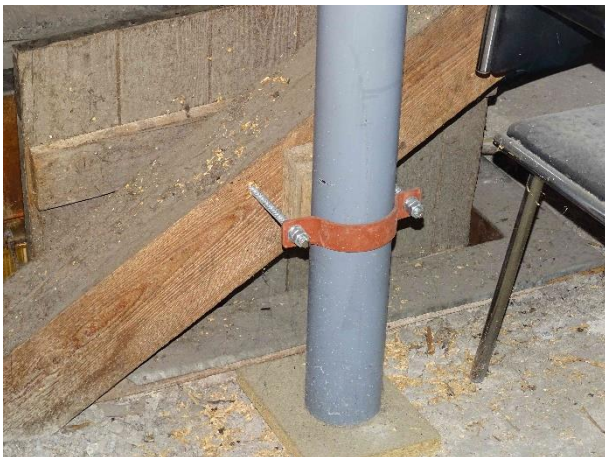
ESN.16 – stávající stožár sirény – kotvení
