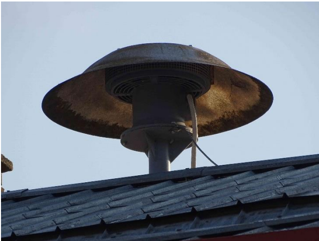
ESN.16 – stávající stožár sirény – příruba
