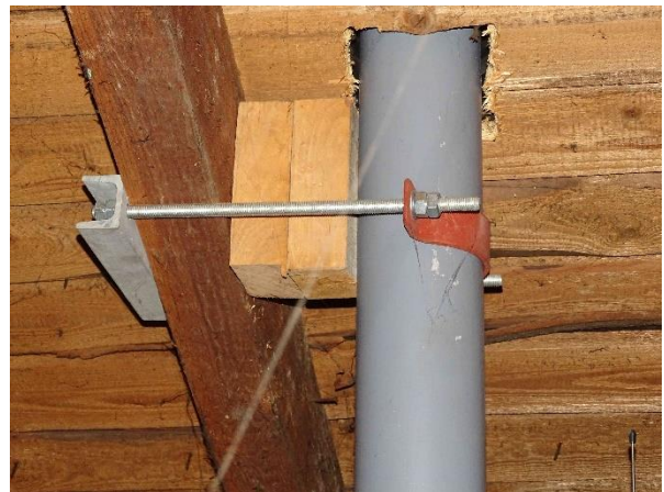
ESN.16 – stávající stožár sirény – kotvení
