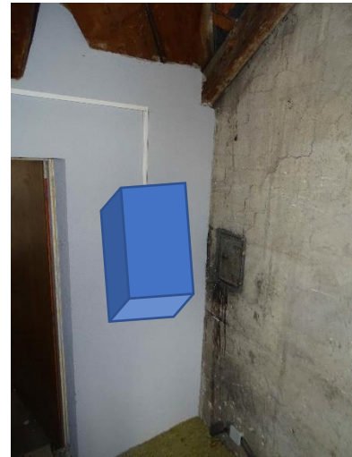
EST.13 – místo pro nový rozvaděč sirény (rozvaděč NN je přes zed')
