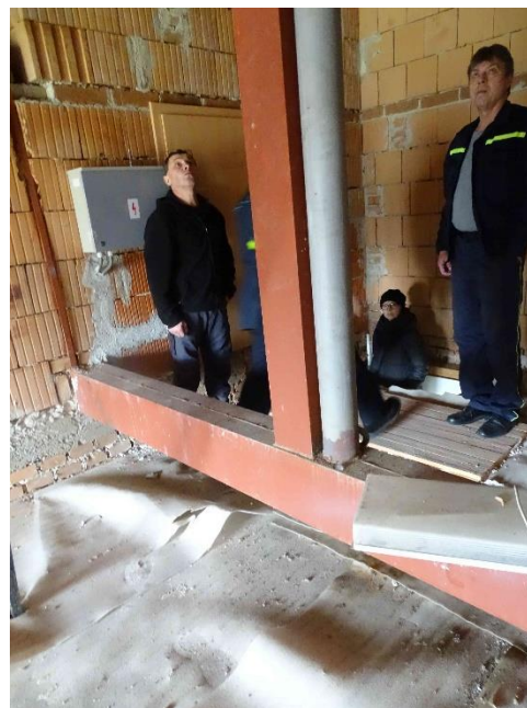
ESN.15 – stávající stožár sirény – kotvení
