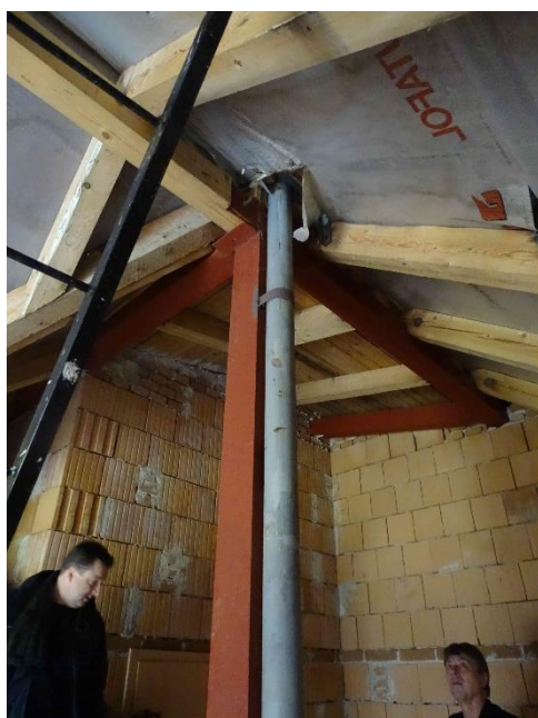
ESN.15 – stávající stožár sirény – průchod na střeše
