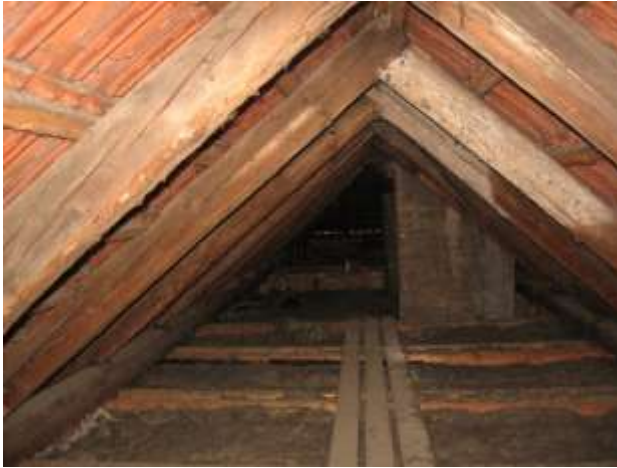
EST.7 – objekt ÚMČ Brno-jih, místo pro nový stožár
