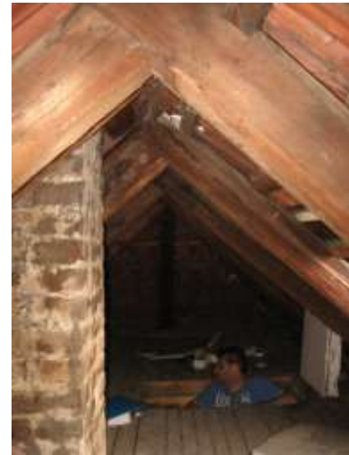
EST.7 – objekt ÚMČ Brno-jih, místo pro nový stožár
