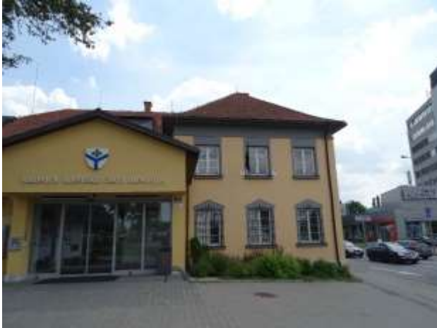
EST.7 – objekt ÚMČ Brno-jih
