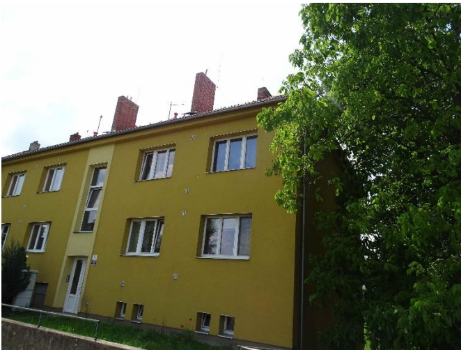
EST.8 – administrativně-technický objekt
