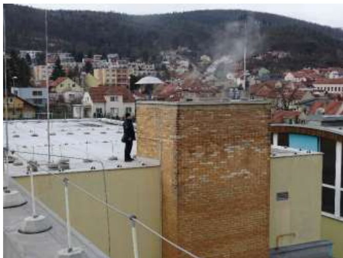
ESN.11 – stávající stožár sirény – hromosvod s jímači
