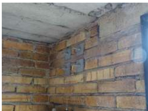
ESN.11 – stávající stožár sirény – detail kotvení
