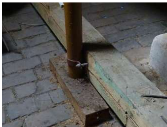
ESN.13 – stávající stožár sirény - kotvení
