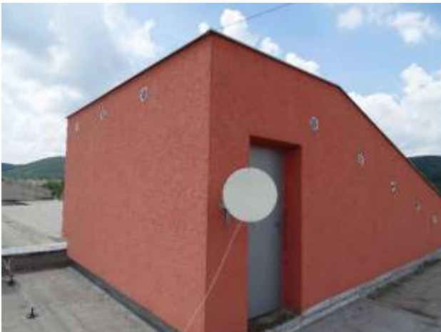
EST.2 – nástavba schodiště na objektu Čichnova 982/23
