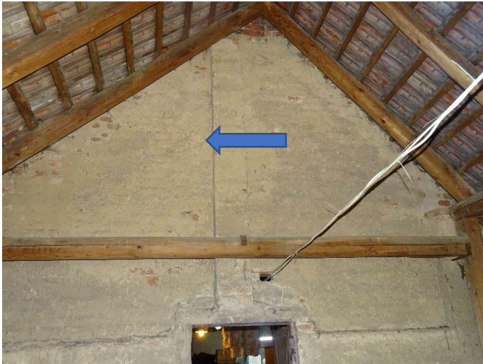
ESN.14 – místo pro nový stožár (kotvení v na horní trám)
