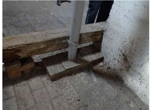
ESN.8– stávající stožár sirény – kotvení
