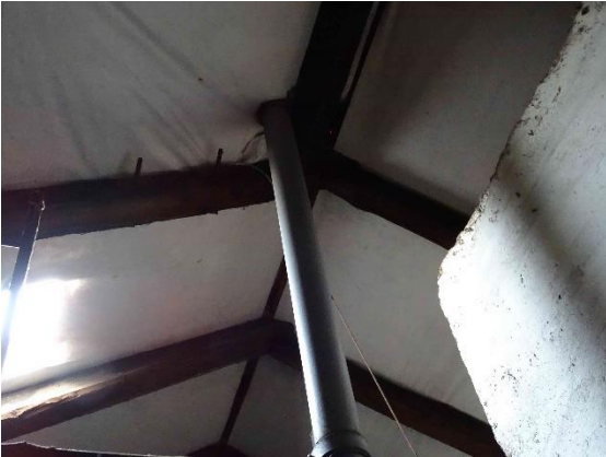
ESN.8 – stávající stožár sirény – průchod na střechu
