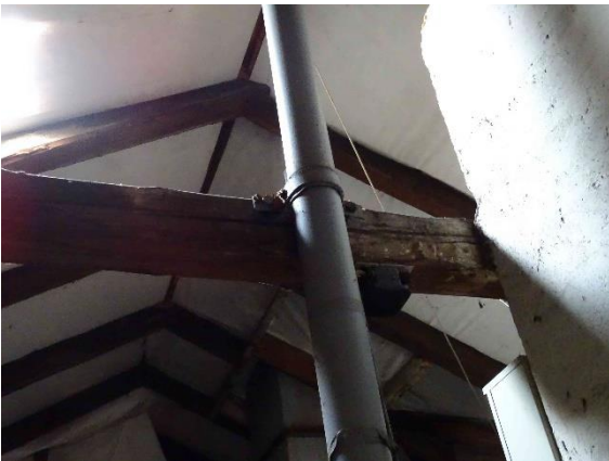
ESN.8 – stávající stožár sirény – příruba
