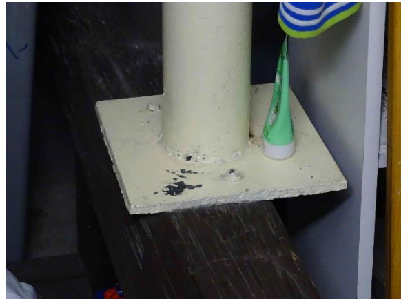
ESN.7 – stávající příruba stožár sirény – kotvení
