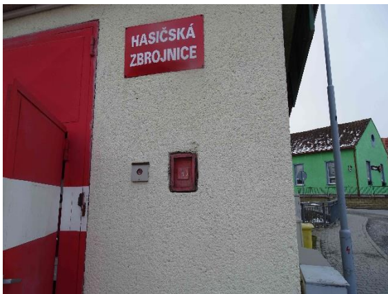
ESN.7 – stávající požární tlačítko – zůstane zachováno
