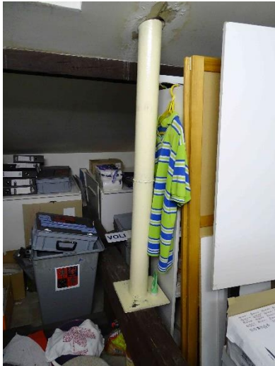
ESN.7 – stávající stožár sirény – průchod na střechu
