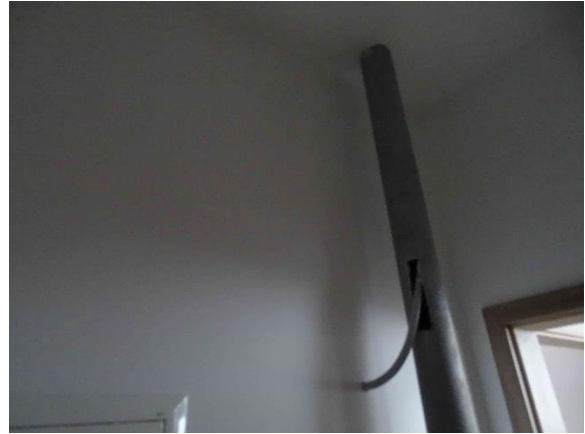
ESN.6 – stávající stožáru sirény – průchod kabelu vnitřkem stožáru
