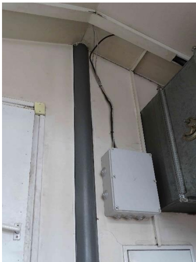
ESN.2 – stávající stožár sirény – průchod na střeche
