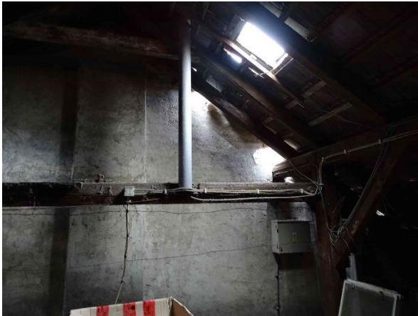
ESN.3 – stávající stožár sirény – průchod na střechu
