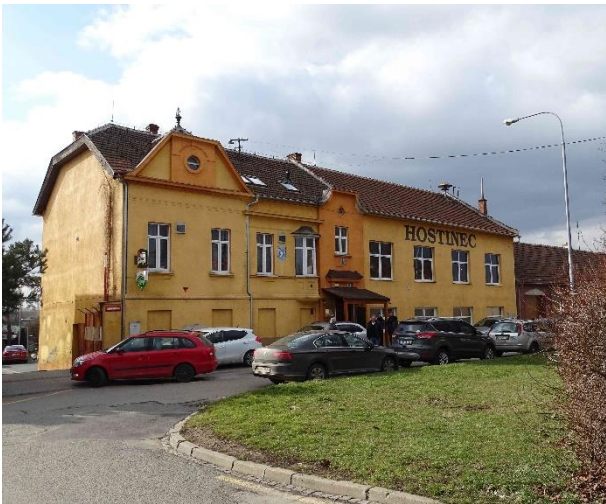
ESN.3 – objekt se stávající rotační sirénou
