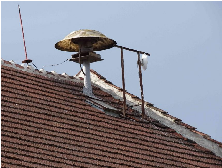
ESN.3 – stávající stožár sirény – příruba a výlez
