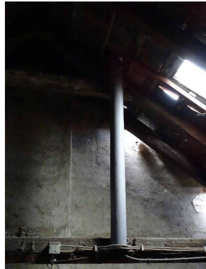
ESN.3 – stávající stožár sirény – kotvení
