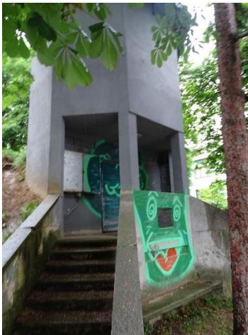
EST.17 – objekt vodojemu
