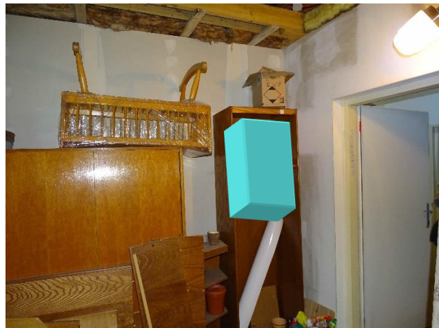
ESN.1 – umístění nového rozvaděče sirény, za dveřmi (místo skříně s policemi)
