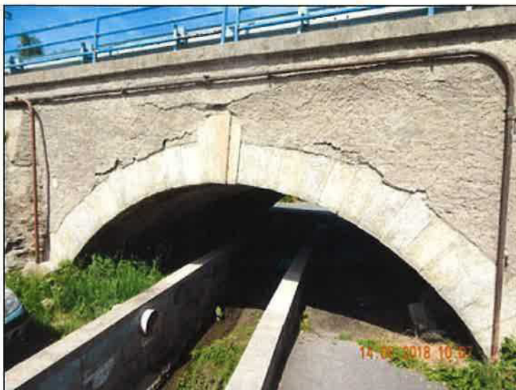
Pohled na pravý bok mostu.
