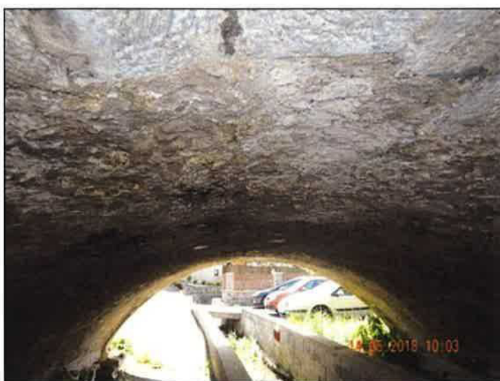
Spodní líc nosné konstrukce
