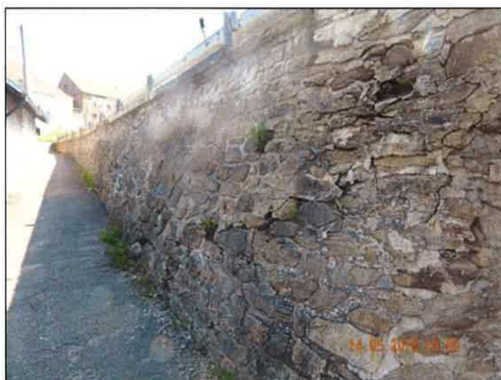
Pohled na navazující čelní zeď na levé straně, plošně vypadlé spárování, místa rozvolněné kameny, uchycená vegetace.
