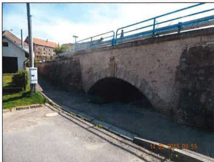
Pohled na levý bok mostu.
