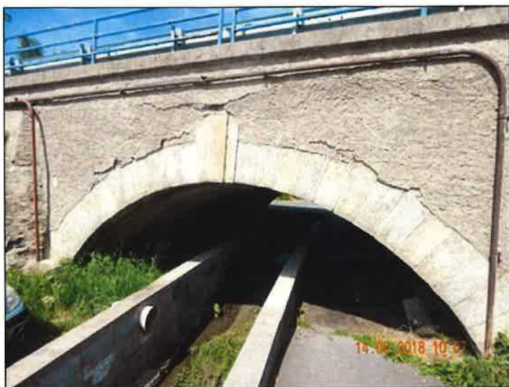
Pohled na pravý bok mostu.
