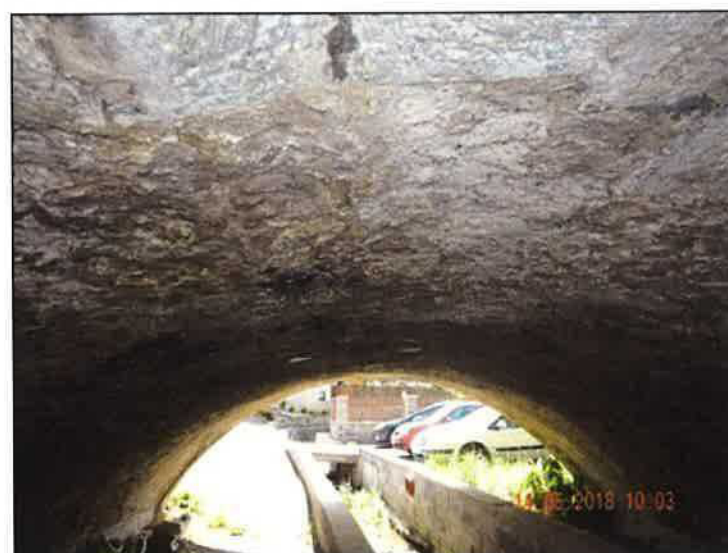
Spodní líc nosné konstrukce
