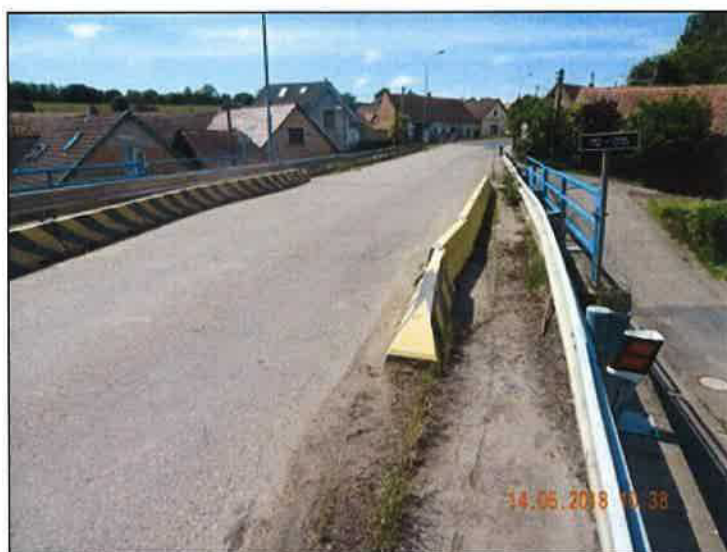
Pohled proti směru staničení.
