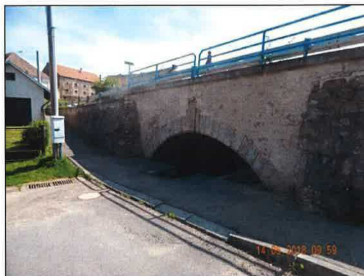
Pohled na levý bok mostu.
