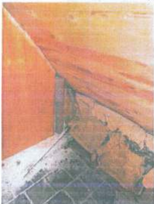
rozpádající se obklad půdiček ve 3.NP
