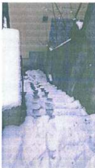
ŽB venkovní schodiště shora
