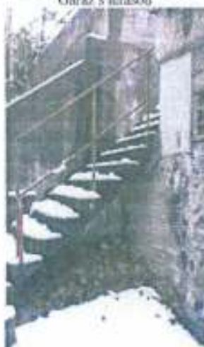
ZD venkovní schodiště
