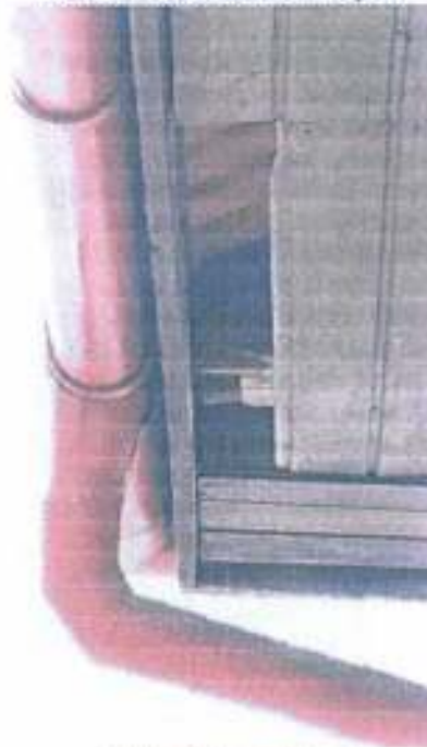
Chybějící podbíjení
