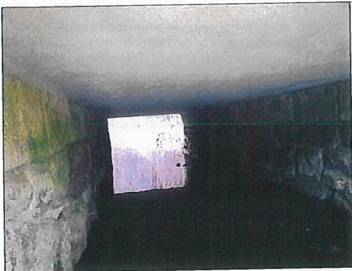
Pohled do mostního otvoru
