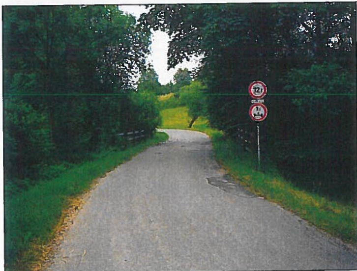
Pohled ve směru staničení
