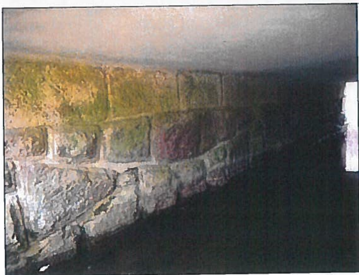
Pohled na líc levobřežní opěry a podhled NK
