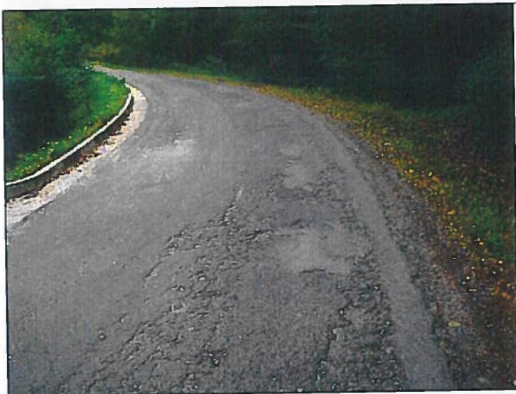
celkový pohled proti směru staničení
