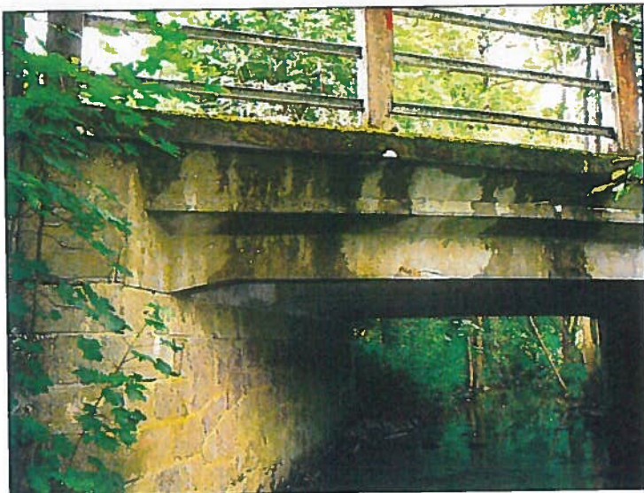
Pohled na pravou stranu konstrukce
