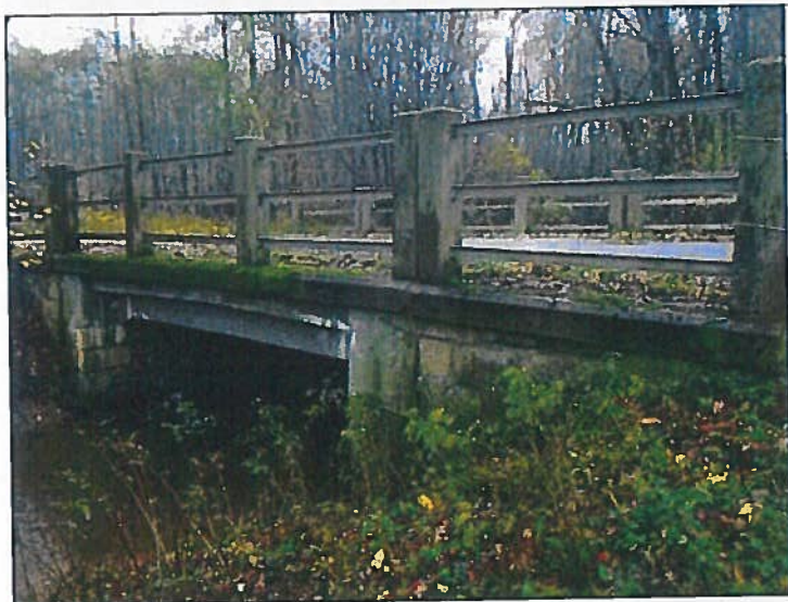
Pohled na vtokovou stranu objektu
