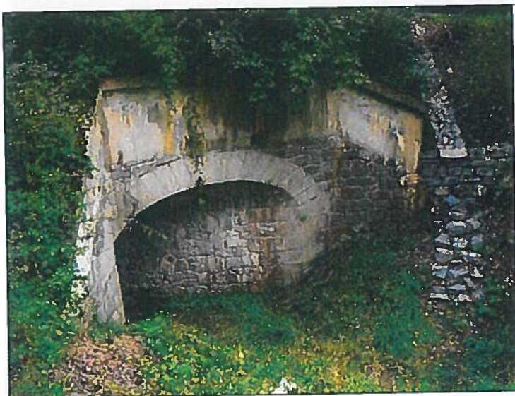
pohled na pravou stranu konstrukce
