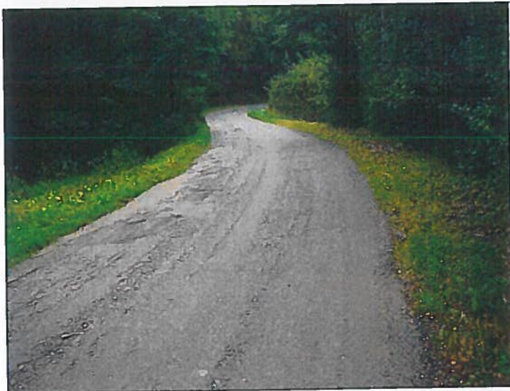
celkový pohled ve směru staničení
