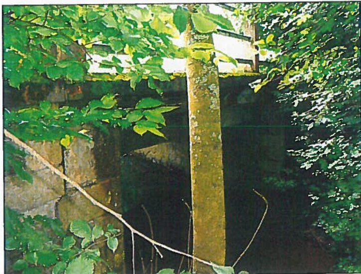
Pohled na levou stranu konstrukce
