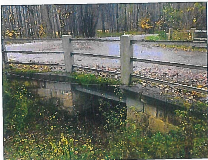
Pohled na vtokovou stranu objektu
