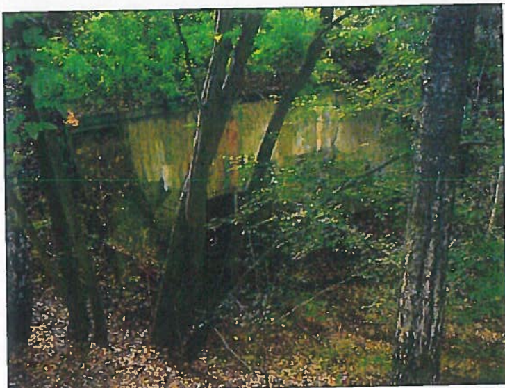
pohled na levou stranu konstrukce
