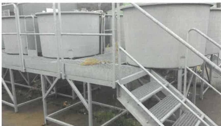
Obr. 2a: Příklad pochozích roštů s ukázkou schodů a velkých nádrží
