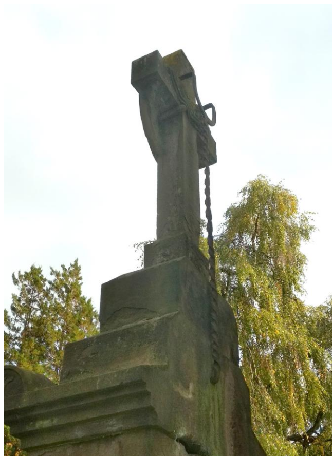
Foto 7 kovářsky torzírované táhlo na zadní části kříže
