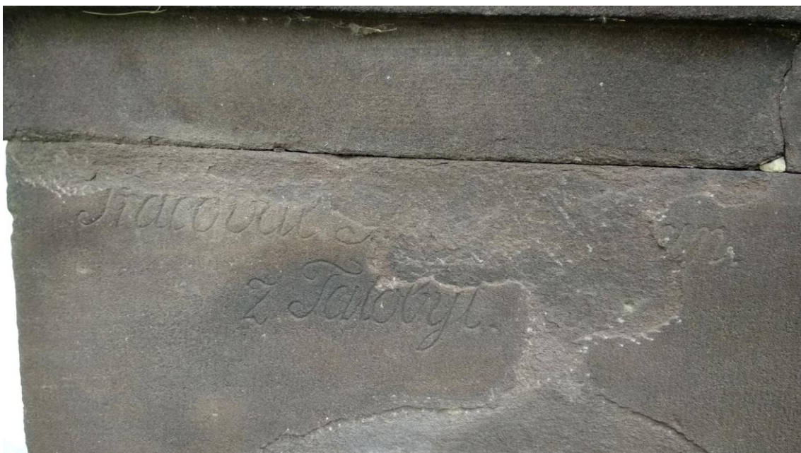
Foto 5 signatura autora náhrobku „Pracoval ...an z Tatobyt“ odfouklé puchýře originálních povrchů v nedávné minulosti někdo kamenicky odstranil, stopy zubáků jsou poměrně dobře čitelné
