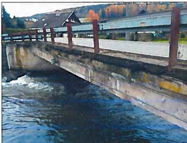
Pohled na vtokovou stranu objektu
