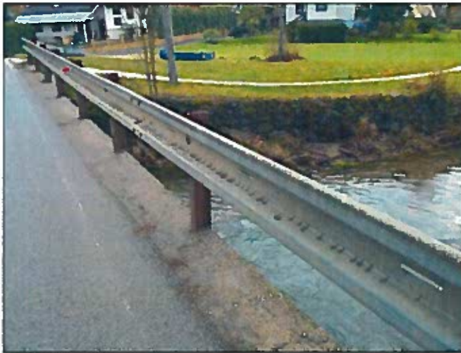
Uspořádání na výtokové římse
