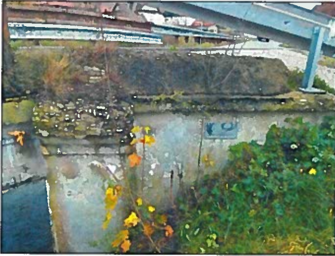
Pohled na levoběžní výtokové křídlo
