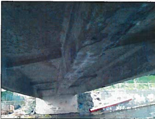
Podhled NK a pohled na pravoběžní opěru
