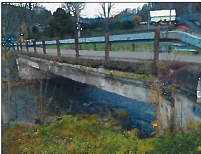
Pohled na výtokovou stranu objektu
