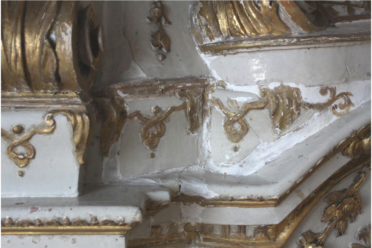
Detail spárování na levém boku
