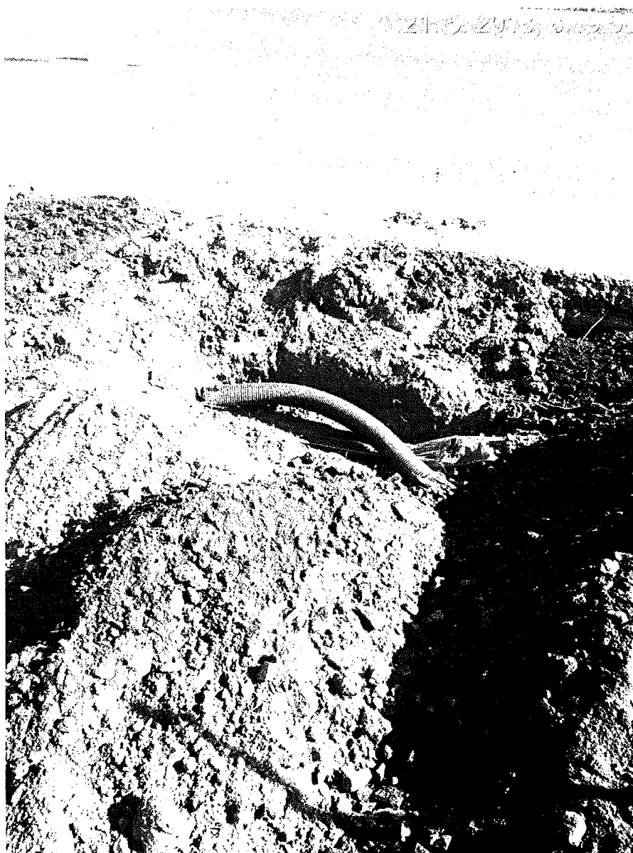
Foto č. 5: Detail přesahu vedení rezervní chráničky za objektem SO 261, směr PHA
