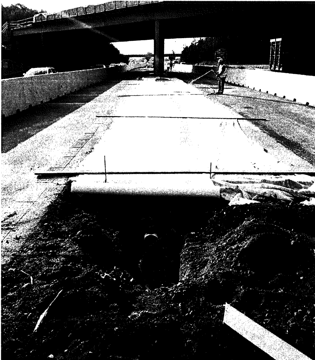
Foto č. 3: Pohled na průběh kabelového vedení za objektem SO 261 v osazené kabelové chráničce a poloha rezervní chráničky před zásypem.
