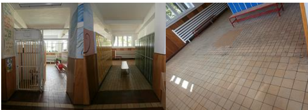
Prostor určený pro zřízení nových skladů, včetně výměny stávající keramické dlažby
