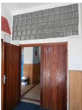
Vybourání dveří a zajištění zvětšení vstupního prostoru
