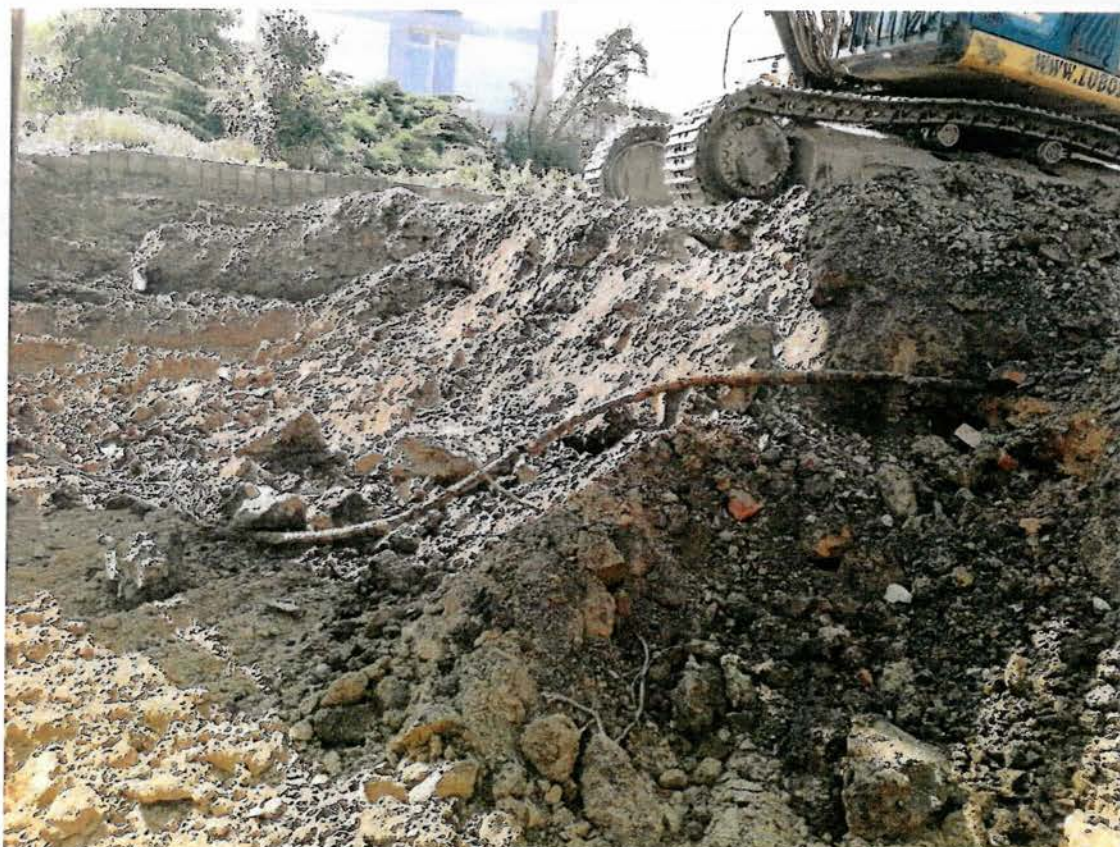
Vytěžená jáma po odstranění betonových bloků
