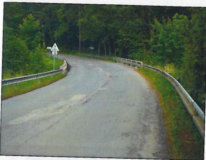
Pohled ve směru staničení
