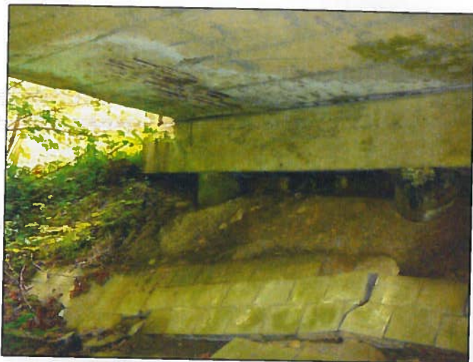
OP1 na pravé straně obnažené piloty
