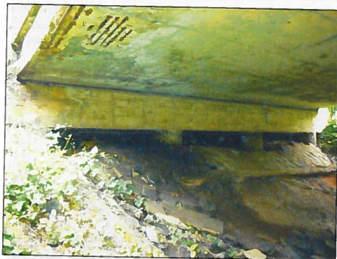
OP2 pokles svahu a obnažení pilot
