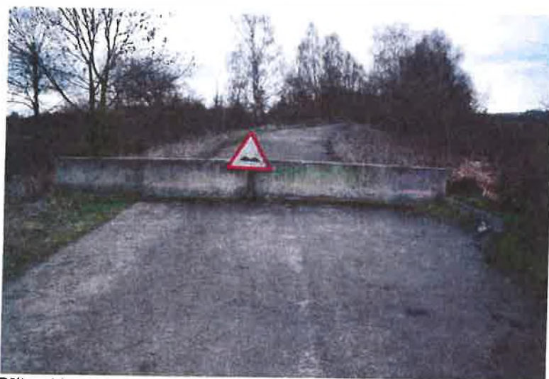
Příjezd k mostu ve směru staničení
