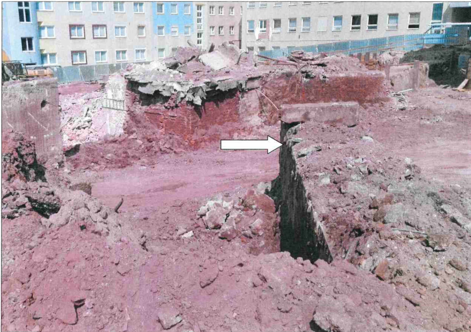
Fotodokumentace energokanálu K3
