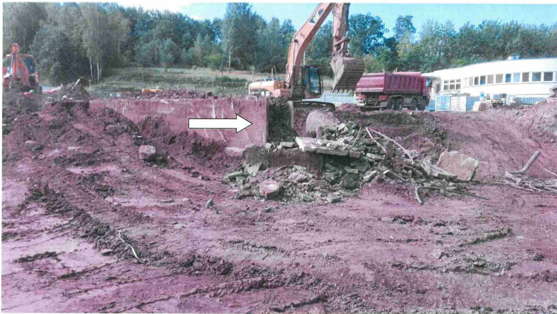
Fotodokumentace energokanálu K3
