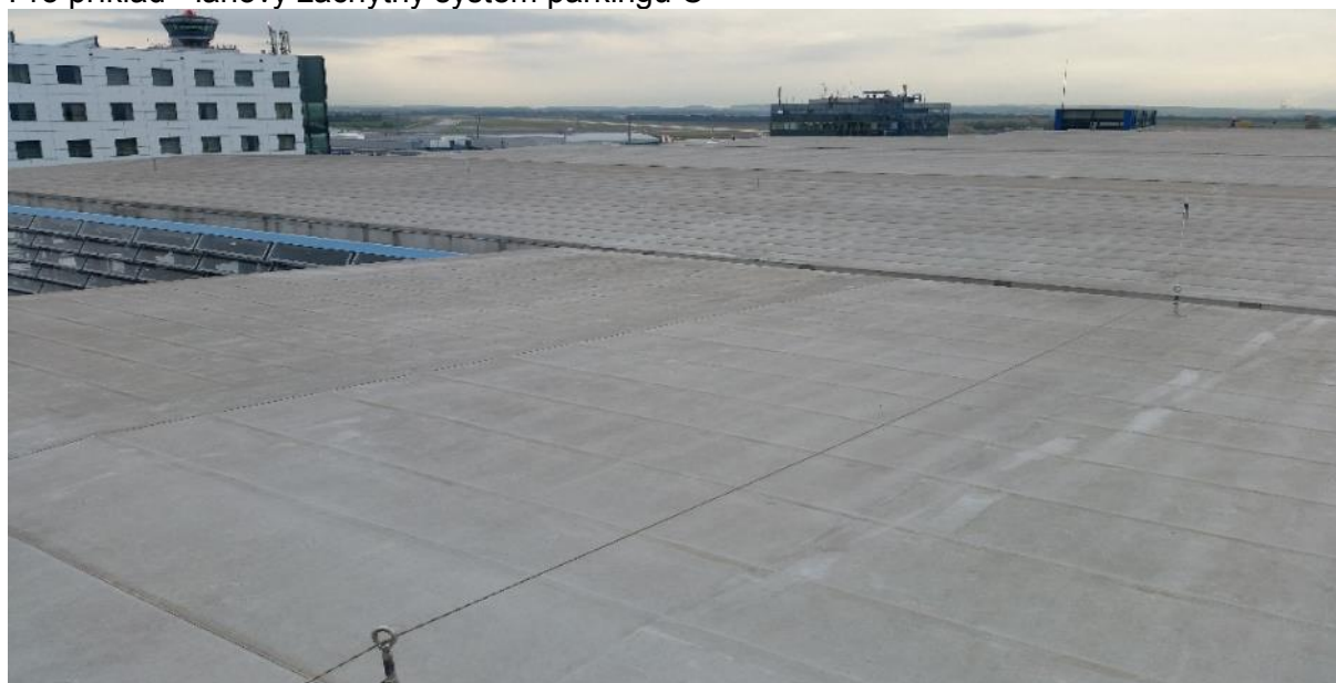
Pro příklad - lanový záchytný systém parkingu C
