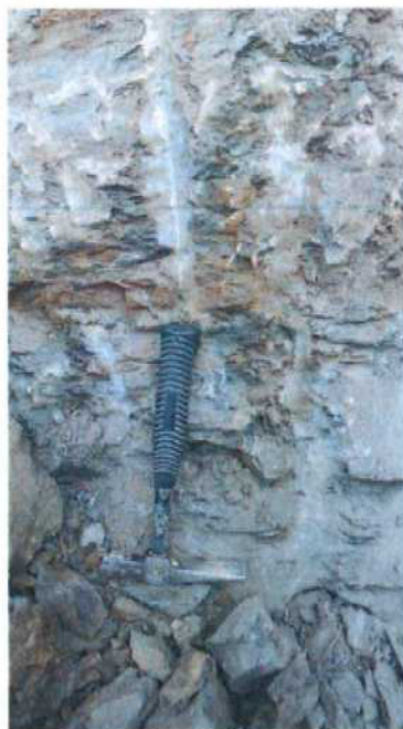
Obr. 2 – jílovité břidlice s nevýraznou horizontální vrstevnatostí ve spodní části výkopu
