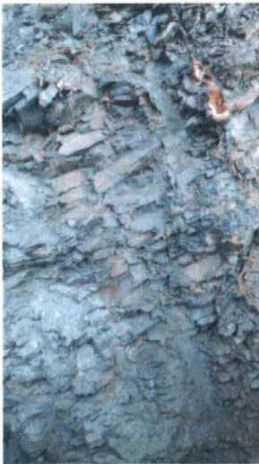
Obr. 1 – mírně zvětralé jílovité břidlice ve svrchní části výkopu (tř. 4)
