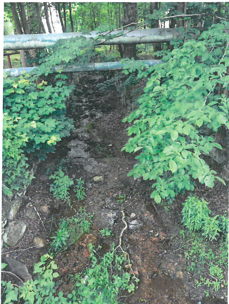
Pohled od mostu k betonové troubě
