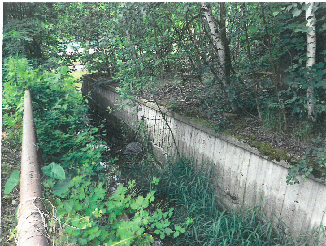
Pohled od mostu k zaústění – betonové zdi
