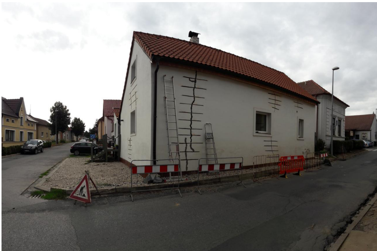
Obrázek 2: Pohled na objekt – sešití zdiva (2018)
