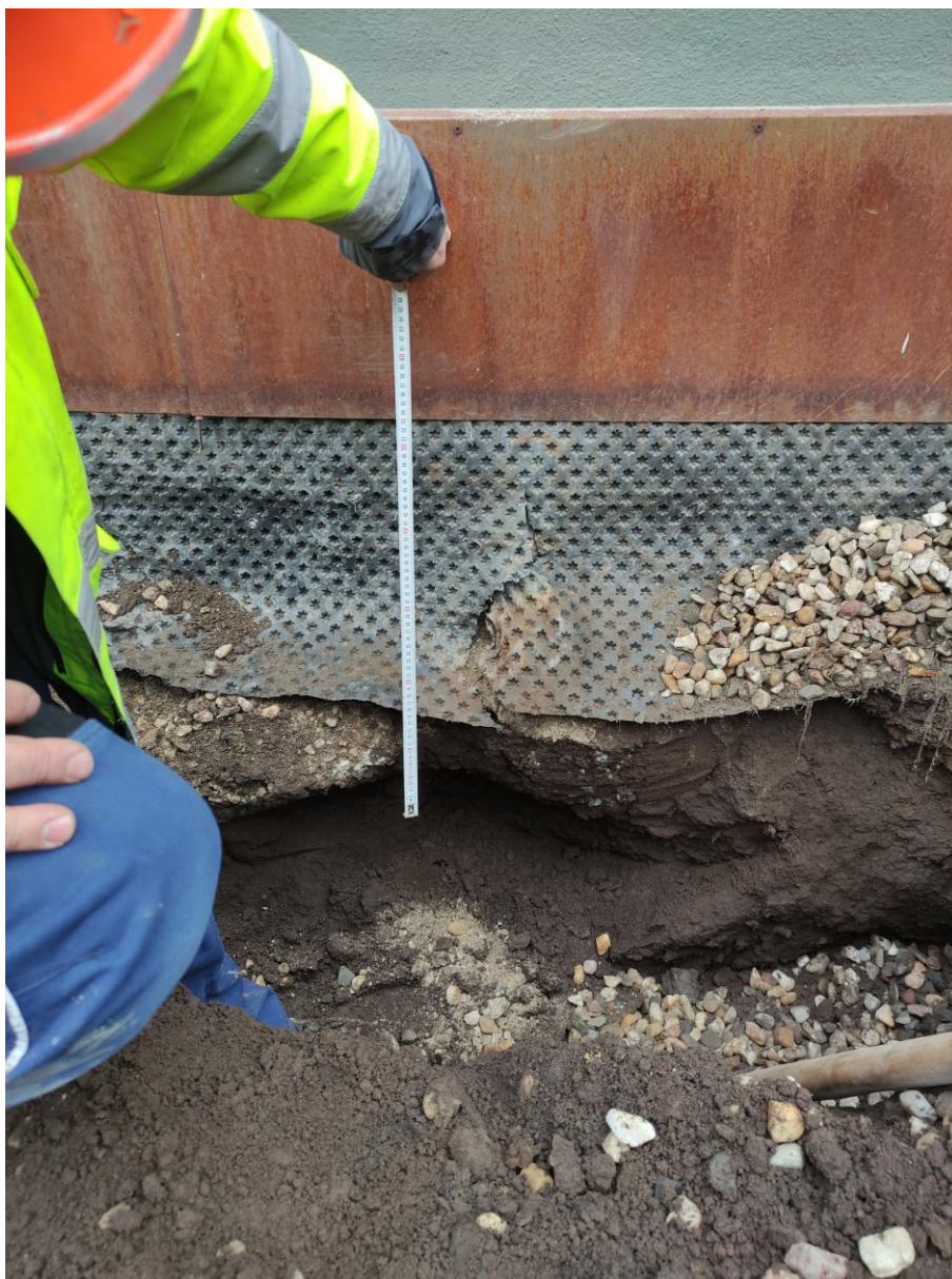
Obrázek 4: Sonda v místě jižního štítu, částečné podbetonování.
