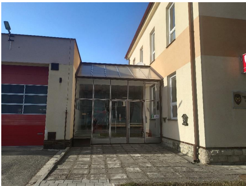
Pohled na stávající prosklenou část vstupního vestibulu HS Vysoké Mýto, z ul. Gen.Svatoše č.p. 207
