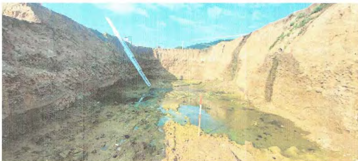
Obr.č. 1 : Pohled do prostoru výkopu hlubokého bazénu . V popředí snímku vrstva splavené rozměklé jemnozrnné zeminy, tl. do 100 mm . Plošné zvodnění základové spáry odpovídá předpokládané hladině podzemní vody na staveništi (361,15 m nm).
