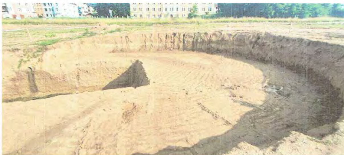
Obr.č. 2: Pohled do výkopu kruhového mělkého bazénu . V mírně svažitém terénu nepřesahuje zahloubení v horní zářezové části 1,6 m . V celém odkrytém půdorysu převažuje litologicky stejnorodá jílovito-písčítá zemina, tuhé až pevné konzistence.
