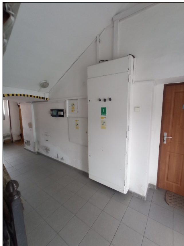
osazení stávajících rozvaděčů v prostoru schodišťové chodby
