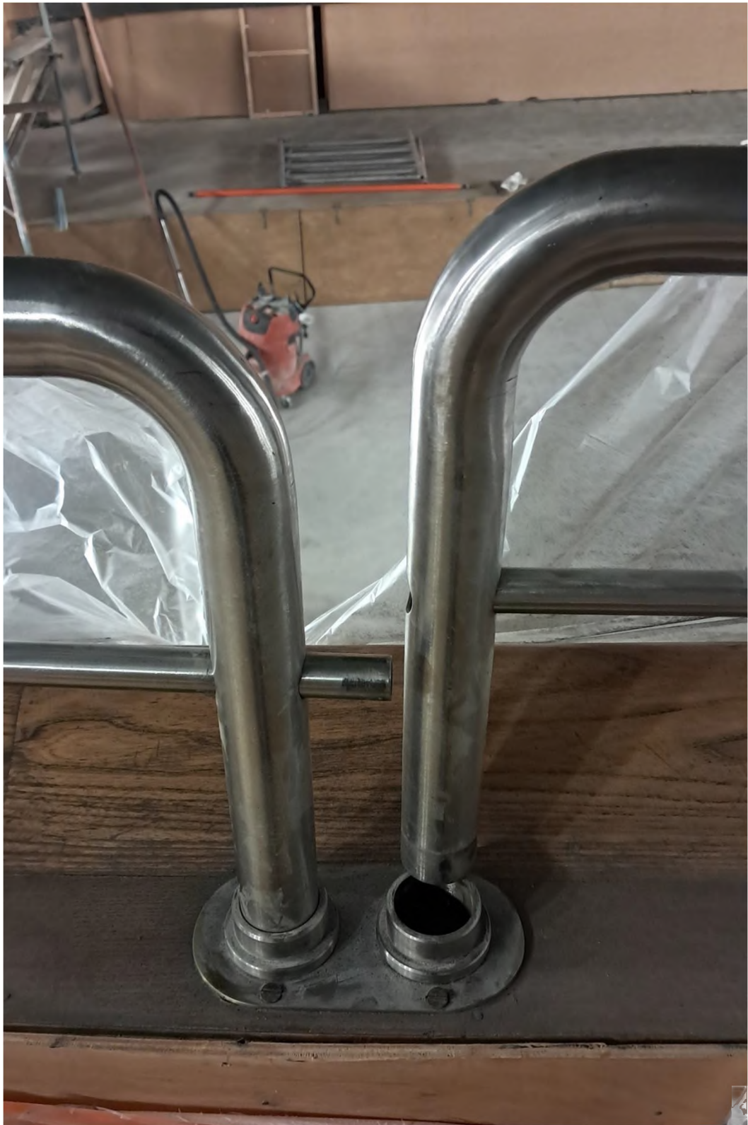
To samé místo před rekonstrukcí.
