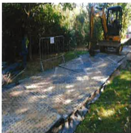
Obr. 45 Ochrana před zhutněním KZ
