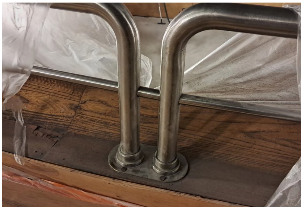
Pohled na sestavu uchycení sousedních bloků a protnutí trubkou průměr 22 mm.
