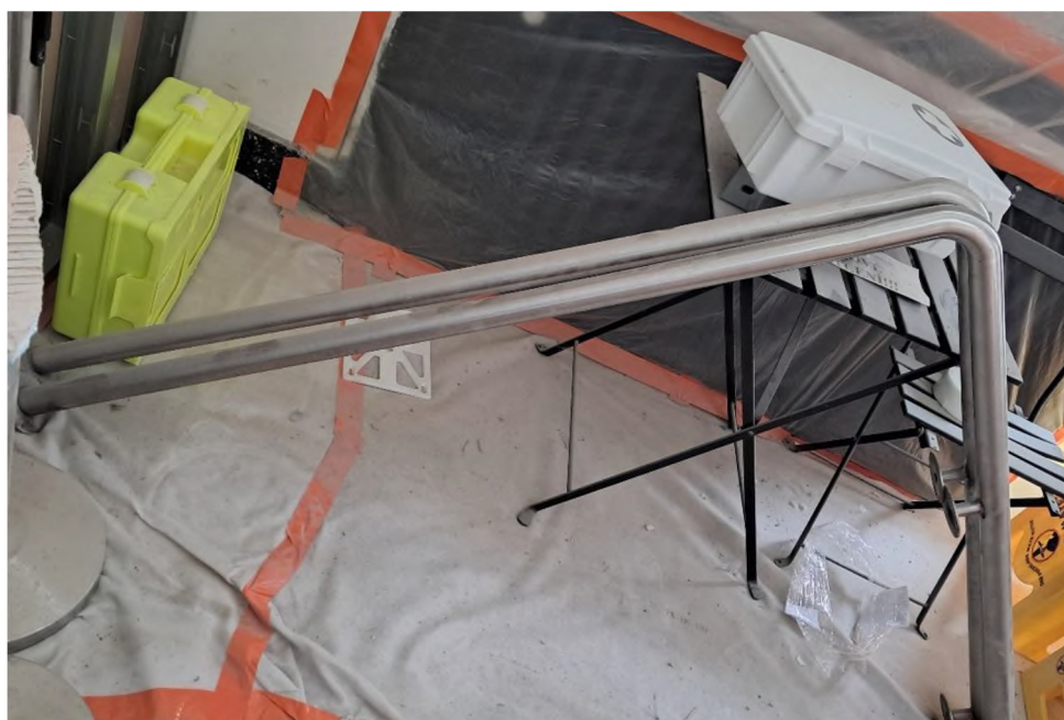
Pohled na pravoúhlá madla, ke vchodu na balkon.
